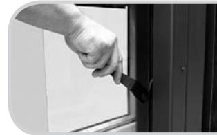
Die „Kalte Hand“ seitlich rechts der Tür auf die Aufnahme/Verschluss aufsetzen und nach oben drehen.
