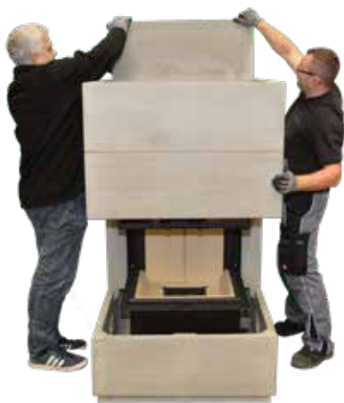
21. Obere Rückwand auf die mittlere Rückwand setzen.
