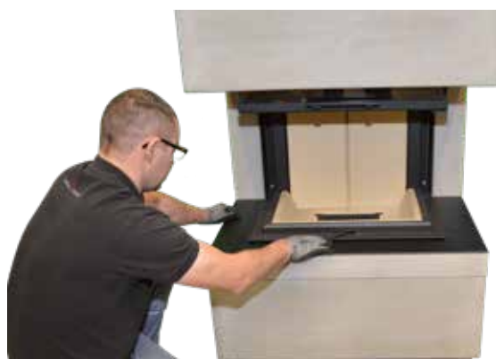
29. Bankplatte aus Stahl auf die Bank setzen, unter die Traverse schieben und ausrichten.
