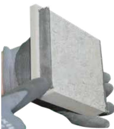
24. Seitliche Dichtbänder (120 mm) rechts und links am Revisionsdeckel aufkleben.
