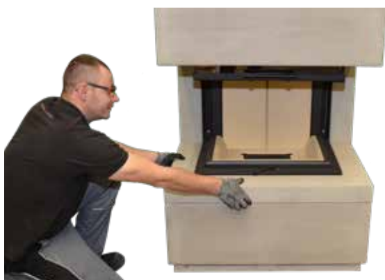
28. Naturstein-Feuertisch oder Bank auf das Unterbauteil setzen und vorsichtig zur Wand schieben! Kamineinsatz evtl. nachjustieren.
