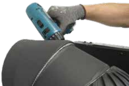
13. Abgaskuppel für waagerechten oder senkrechten Anschluss montieren.
