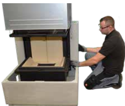
17. Zweites Seitenteil ohne zu verkleben auf das Unterbauteil setzen und ausrichten (Kamineinsatz evtl. nachjustieren). Tragrahmen wieder montieren.
