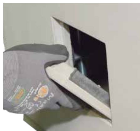
25. Revisionsdeckel schräg von oben in die Öffnung und vor die inneren Anschläge drücken. Zur Demontage bitte nur im unteren Bereich auf den Deckel drücken.
