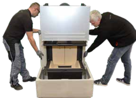
16. Seitenteil (mit integrierter Hinterlüftung) ohne zu Verkleben von oben, mit der Sichtseite außen bündig auf das Unterbauteil setzen. Hinterlüftung zur Wandseite!
