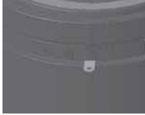
Abb. 4.21 Verbrennungsluftschieber: ganz rechts - Luft ganz geöffnet
